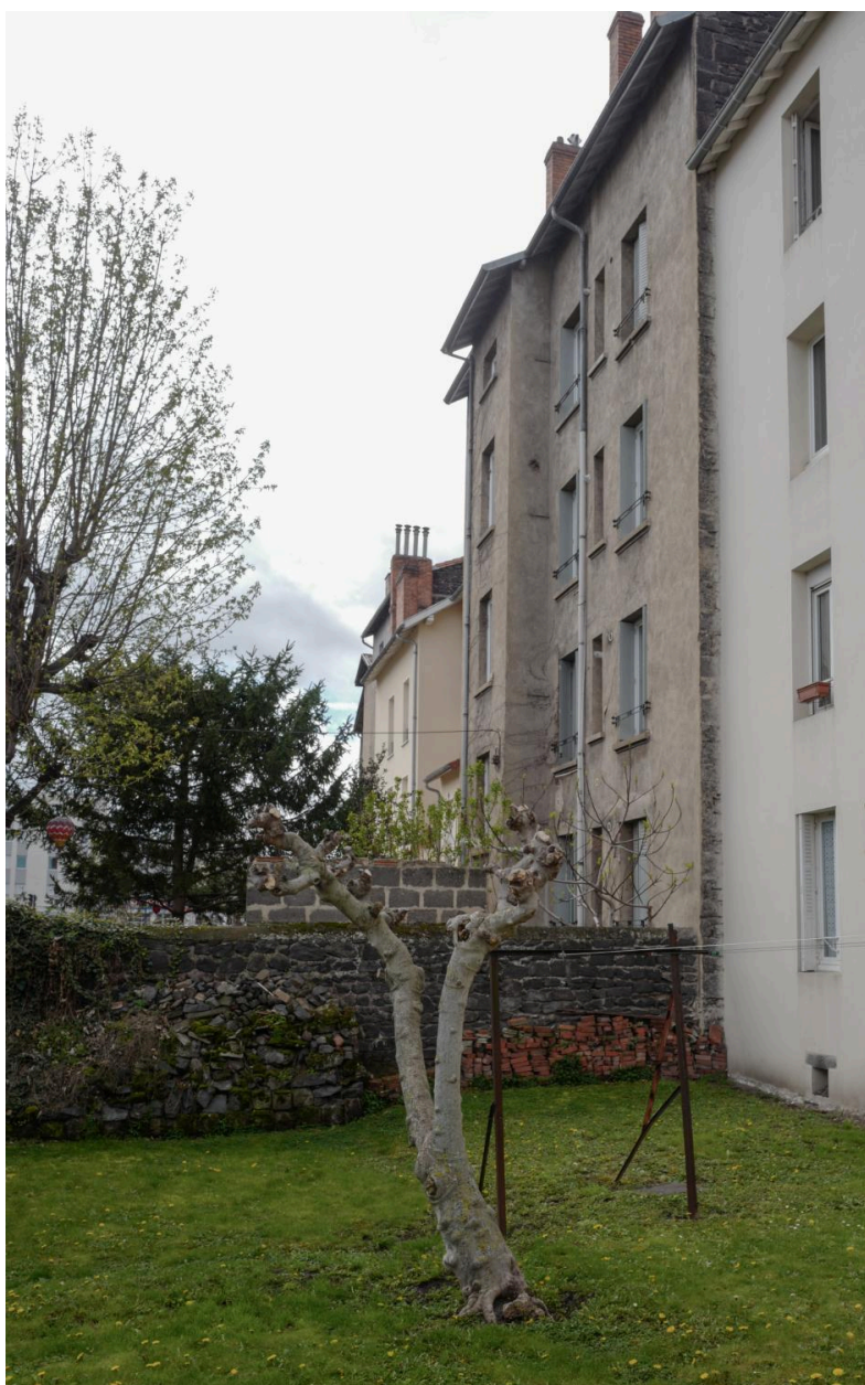
Façades postérieures sur les jardins
