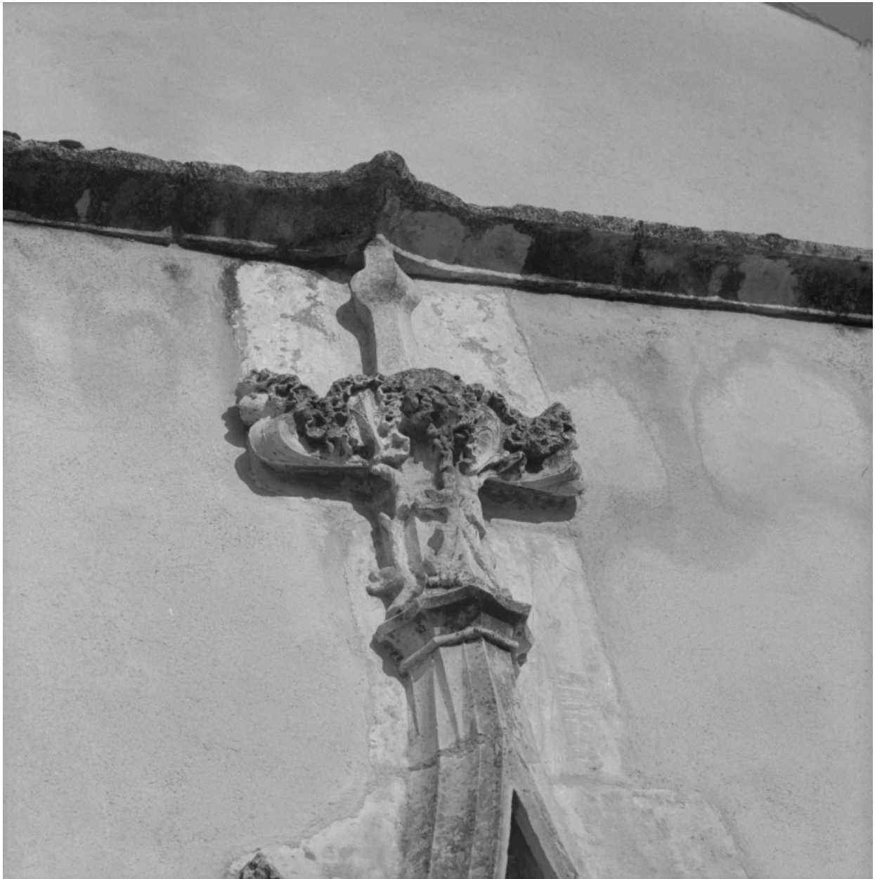
Portail, détail : motif d'amortissement du gâble.
