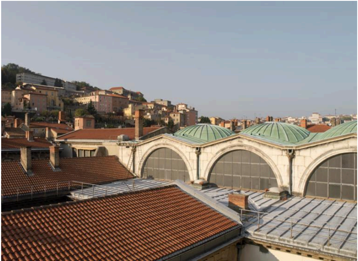
La toiture, vue partielle
