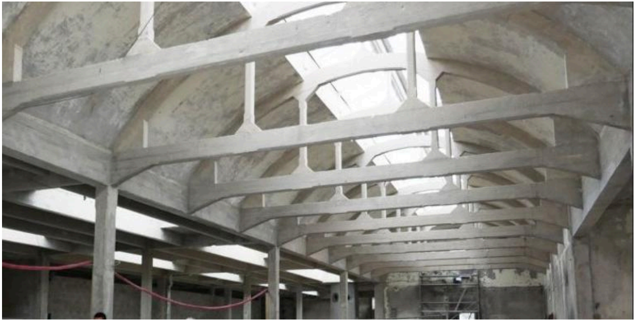
Charpente en béton de l'usine Proplan futur musée de l'industrie textile (archive Ville de Vienne)
