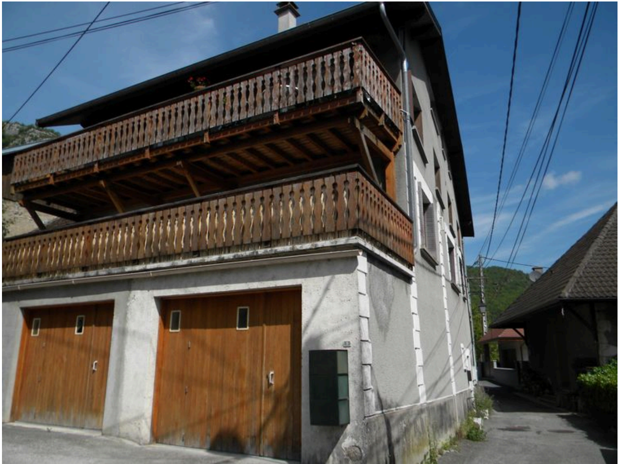
Façade sud d'une maison transformé (2008 A3 282).
