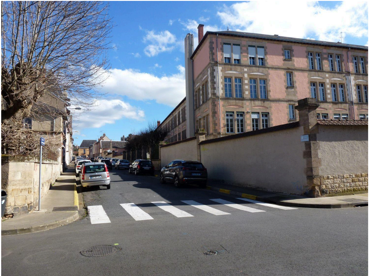
Rue Antoine-Dauvergne : élévation nord du lycée.
