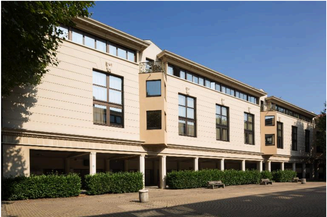
Vue de la façade sur cour
