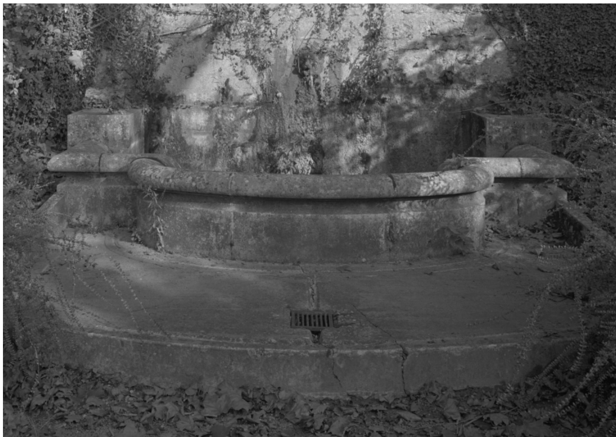
Fontaine adossée au mur de soutènement de la terrasse.
