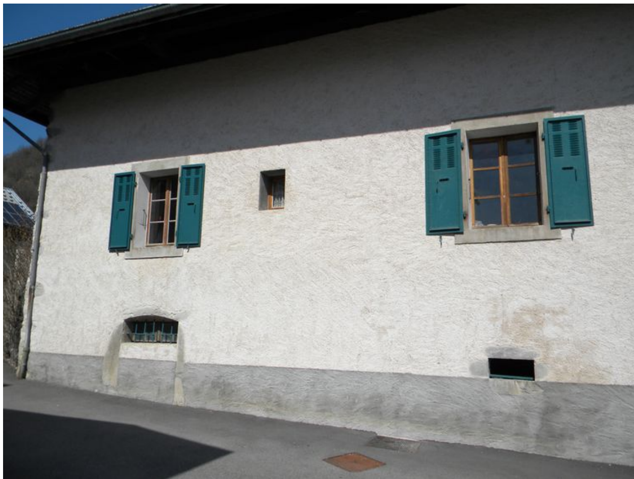
Vue du pignon sud.
