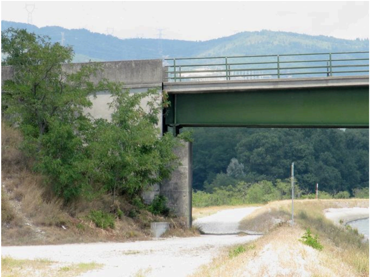
Culée droite, face aval, vue générale (depuis la rive droite)
