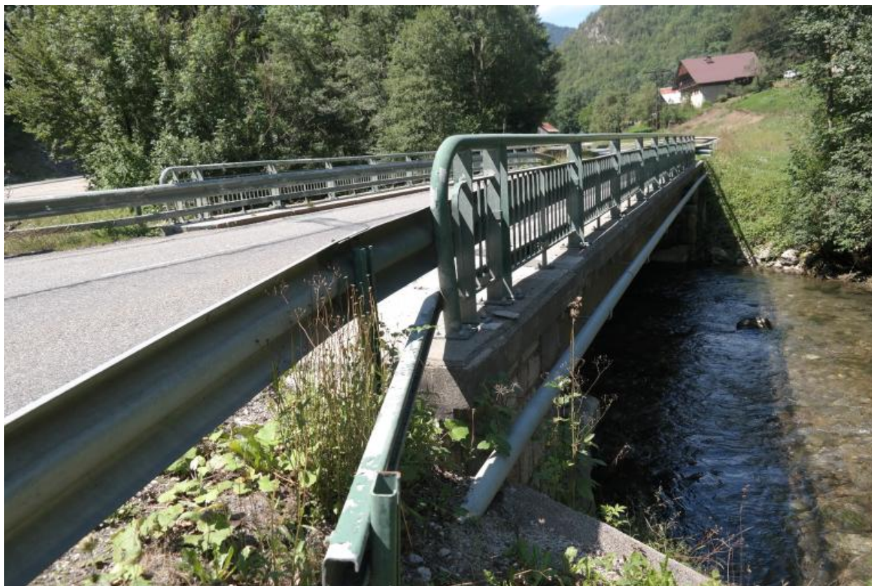
Vue générale du pont des Portes
