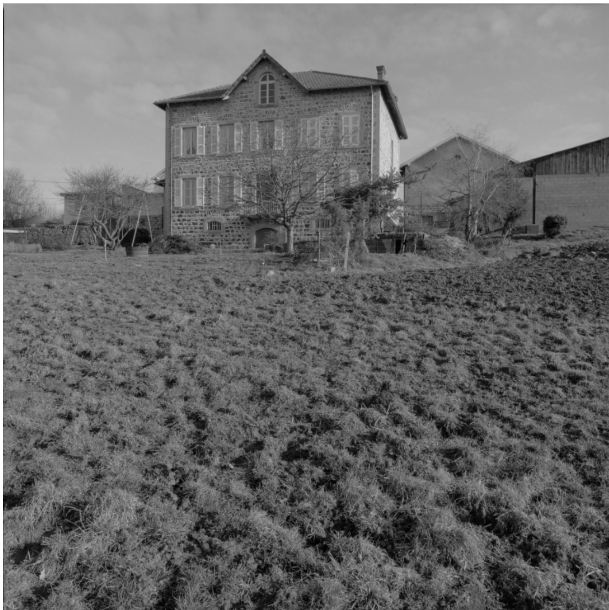
Vue d'ensemble de la façade postérieure.
