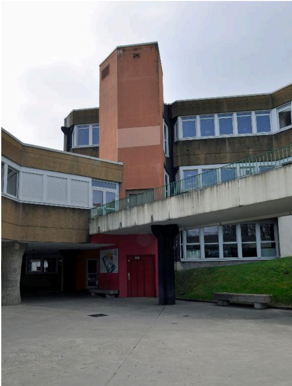
Bâtiment A, élévations nord-ouest et passerelle d'accès au bâtiment E
