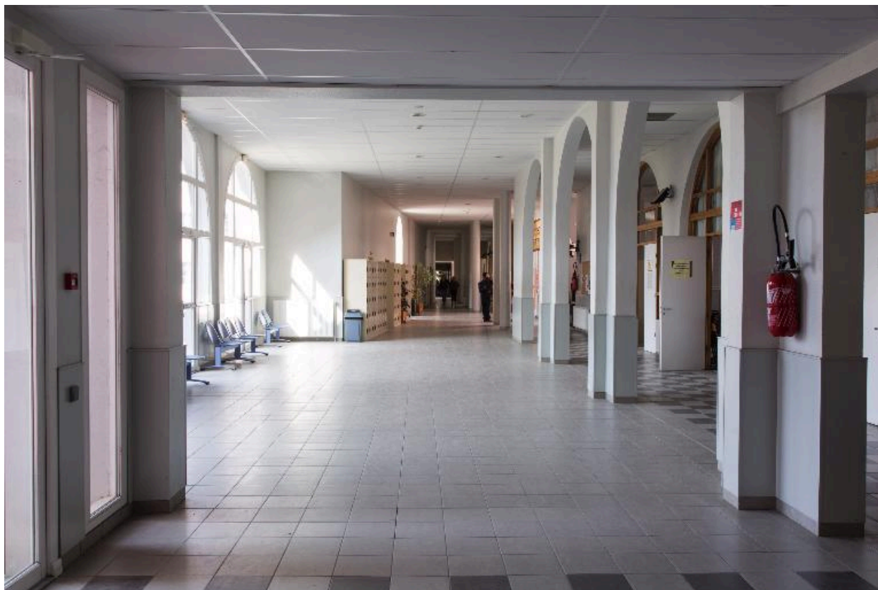
Bât. A : couloir de distribution
