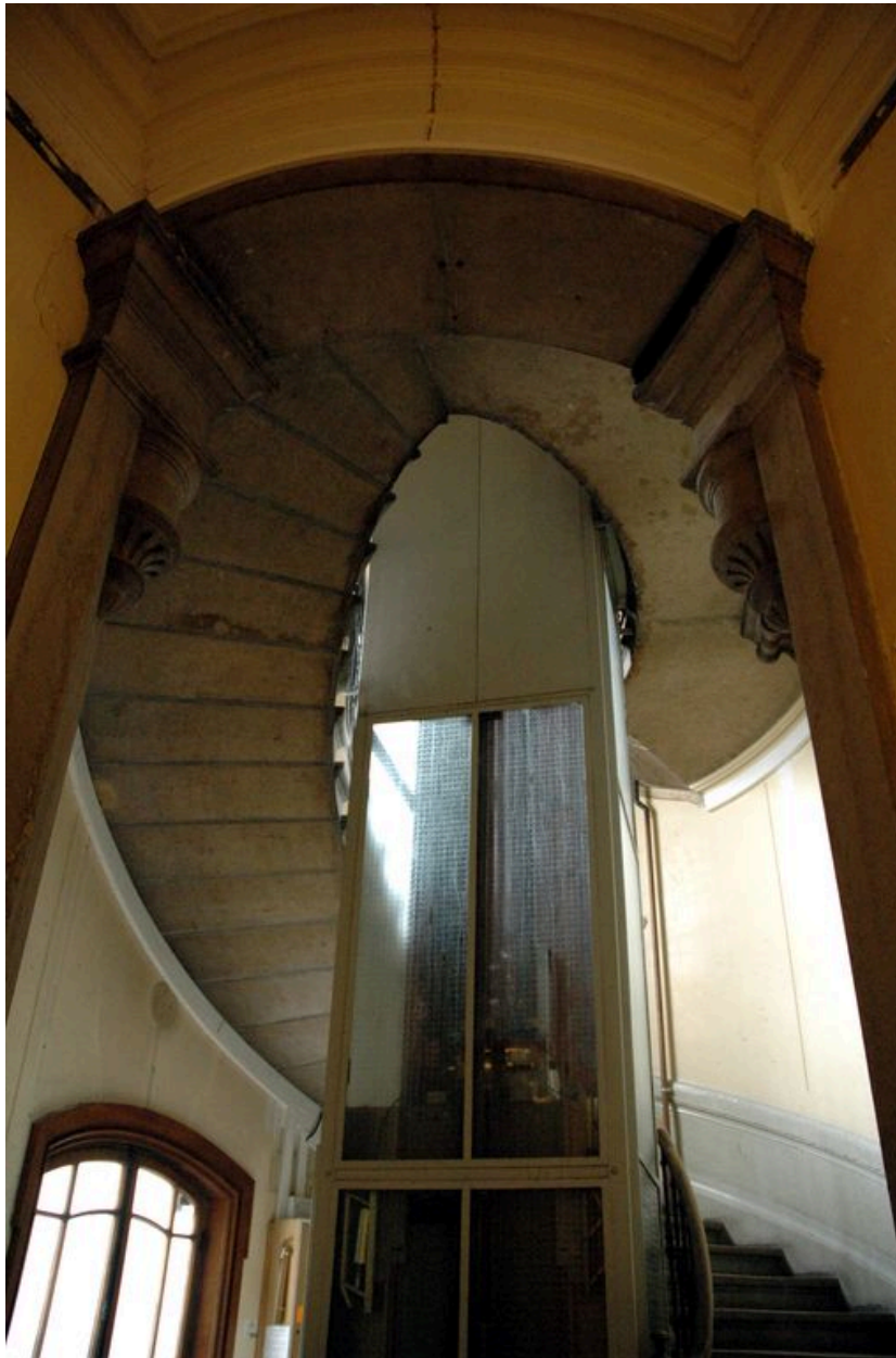
Vue de la cage d'escalier
