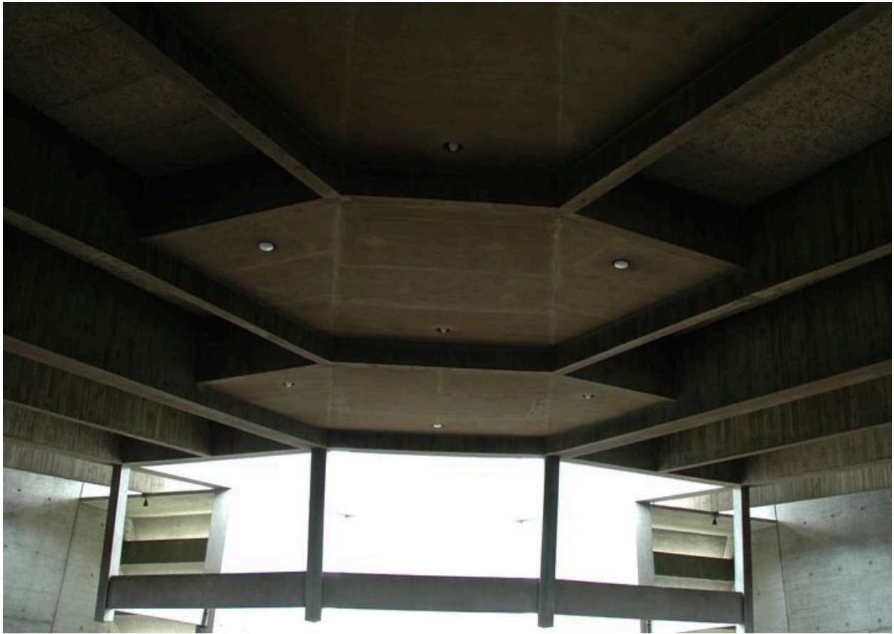
Vue du couvrement de la nef depuis les tribunes
