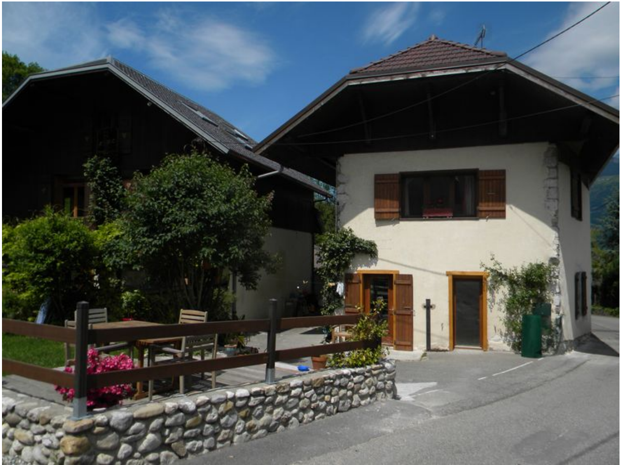
Façade nord d'une ancienne ferme (2008 C8 3272, 1916)
