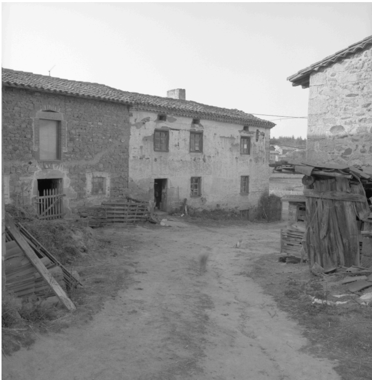
Marcoux, Bruyère (1986 B3 786), type A1. Façade antérieure du logis ancien en pisé et de l'étable en moellons, depuis la cour.
