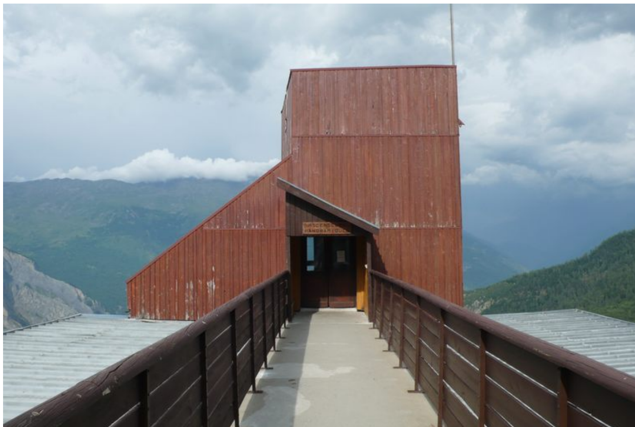
Entrée de l'ascenseur panoramique vers le bas de la station
