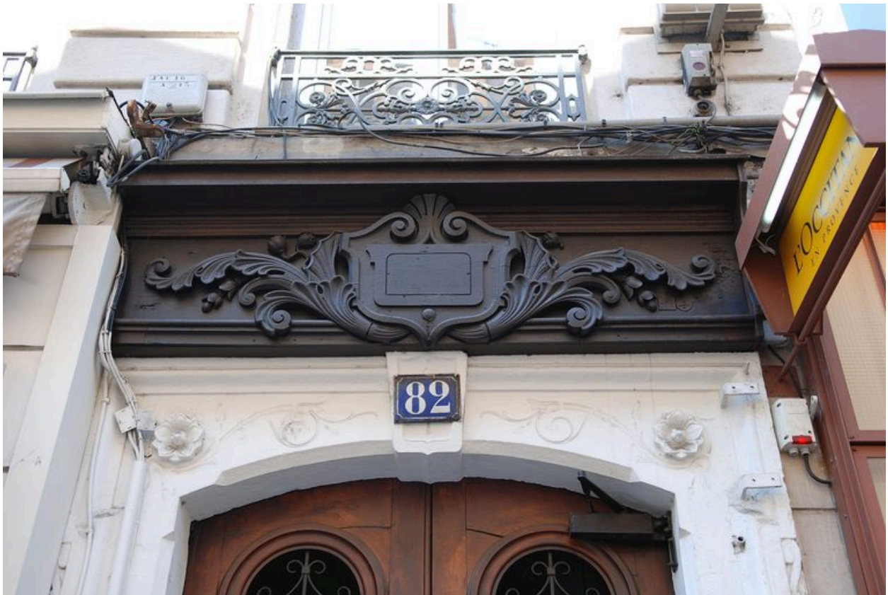
Elévation rue du Président-Edouard-Herriot : détail de la porte
