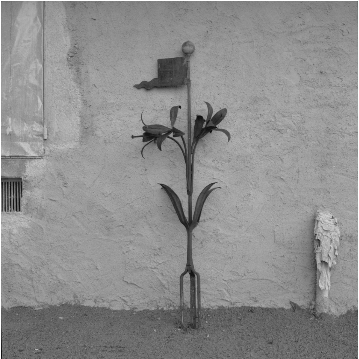
Vue d'ensemble d'un des deux épis de faîtage du toit de la maison. Fleurs de lys en fer forgé et girouette.
