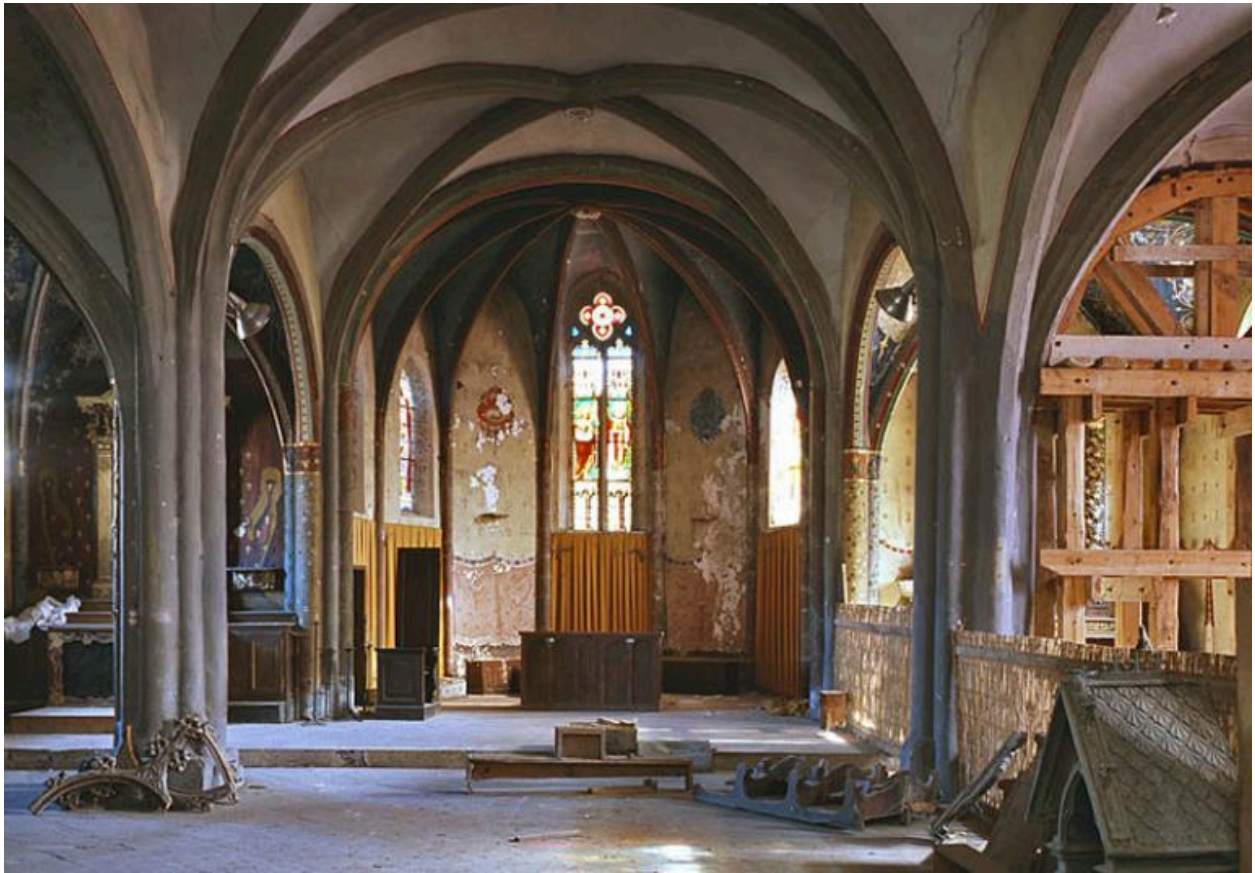
La nef centrale de l'église, en direction du chœur.
