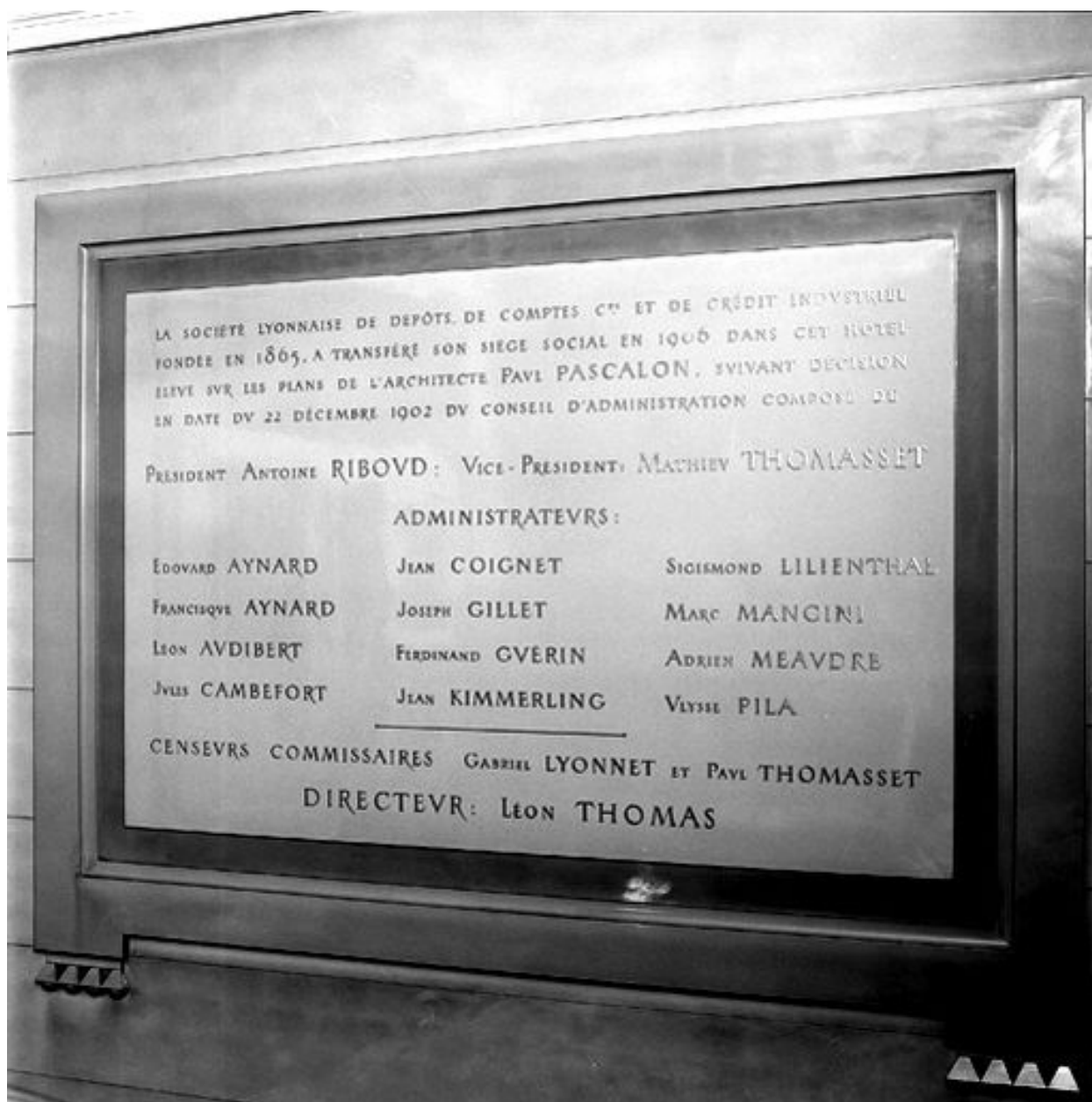
Plaque commémorative de la construction de la banque au 2e étage de la cage du grand escalier
