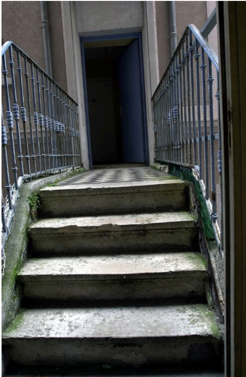
Passerelle desservant le 1er étage
