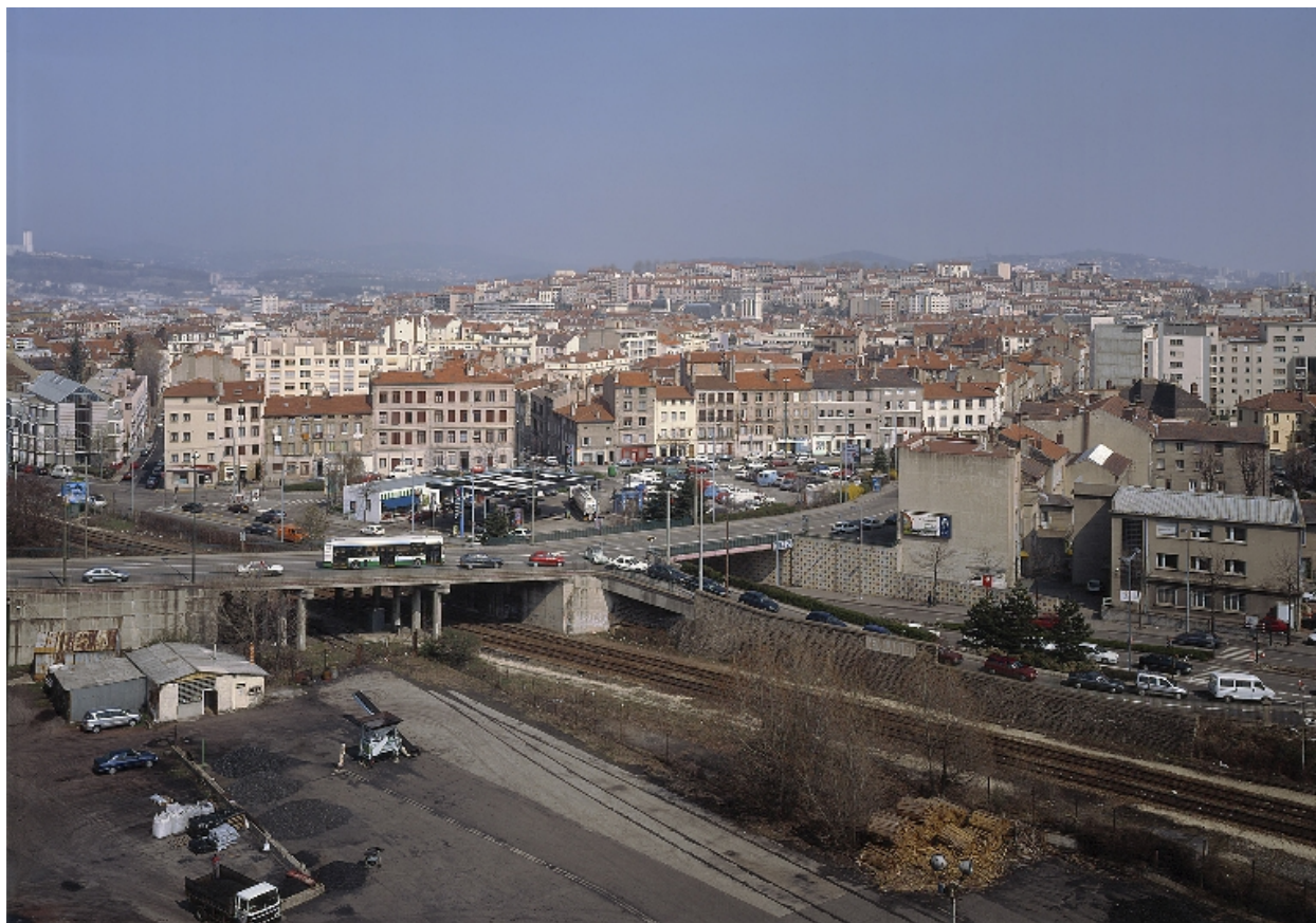
Vue générale des immeubles en front de la place Pareille, le centre ville en arrière plan. Au premier plan, la voie ferrée Saint-Etienne - Le Puy
