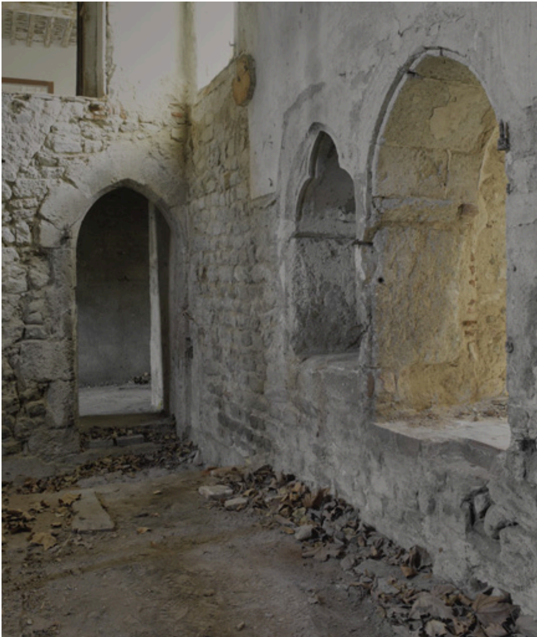
Détail de l'angle sud-est de la chapelle.
