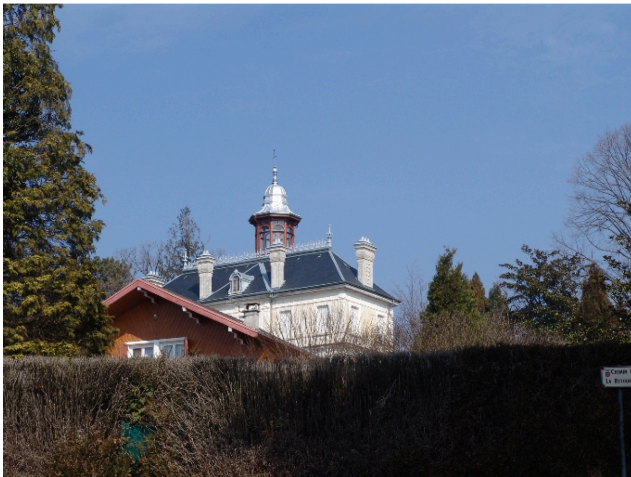
Vue des toitures
