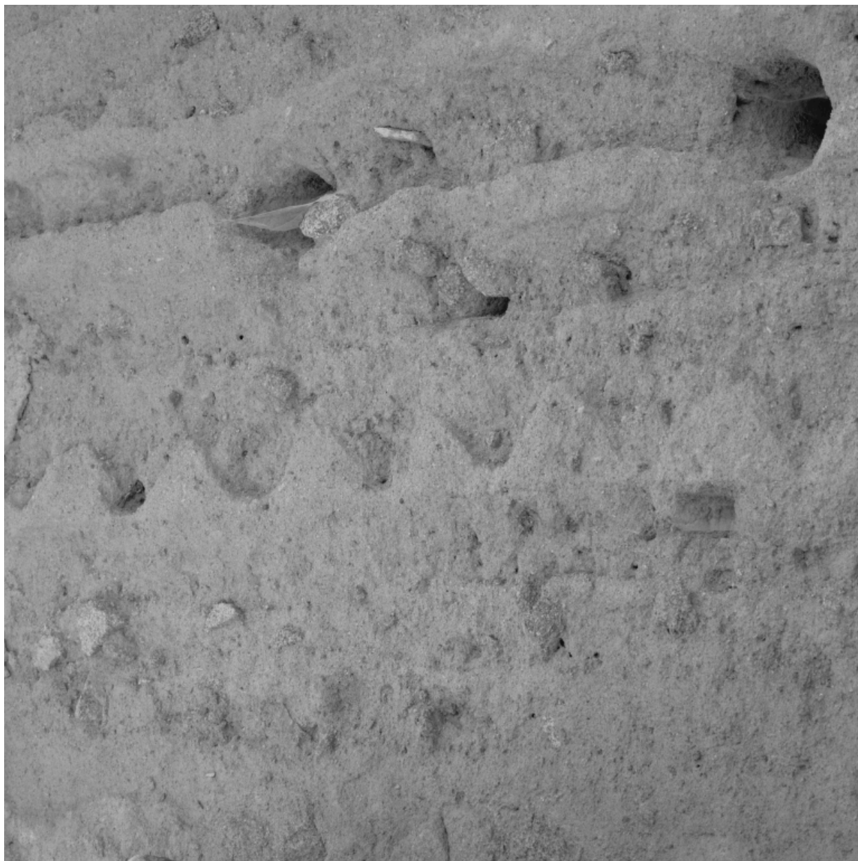
Détail du pisé de la façade antérieure du cuvage.
