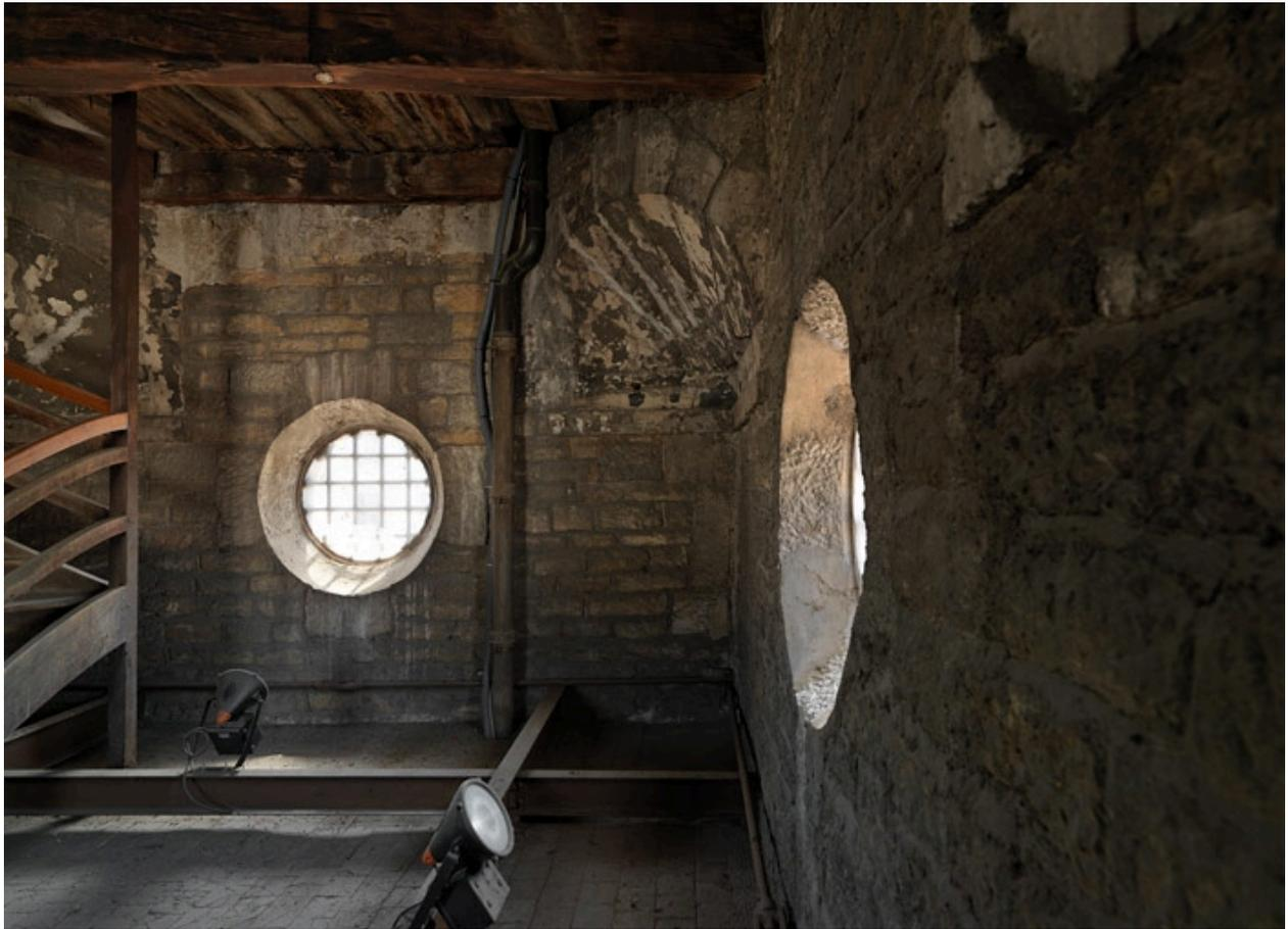
Clocher, deuxième étage : détail d'une trompe permettant de passer du plan carré de la tour au plan octogonal de la lanterne
