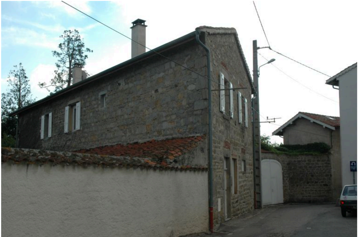
Rigaud, ferme, maison de gardien, 1986 AB 61. Vue d'ensemble depuis le rue.
