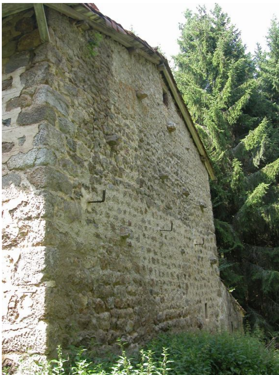
Vue d'ensemble du mur pignon est.
