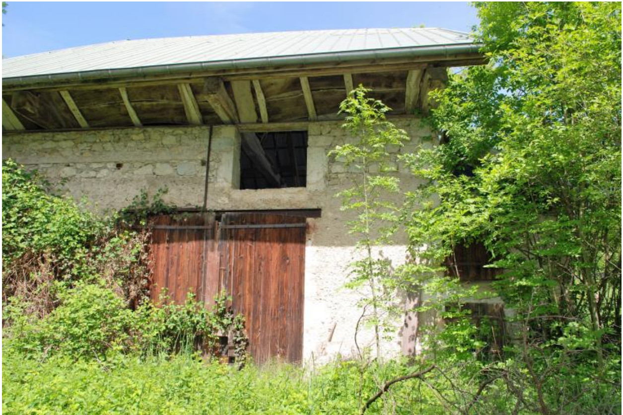
2015 E3 198, Lachat, grange-étale. Vue partielle de la façade avant.
