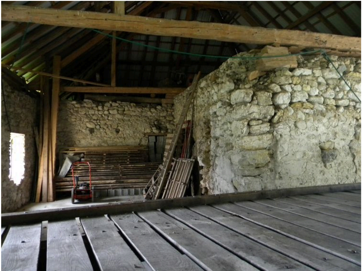
Intérieur et vue de la maçonnerie.
