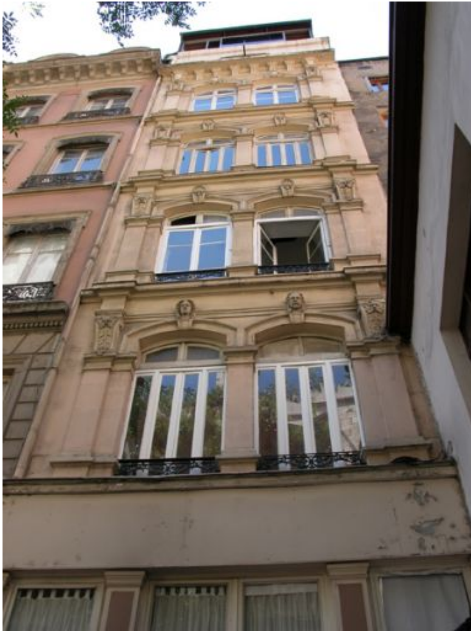
Façade principale rue Saint-Nizier, vue générale par-dessous
