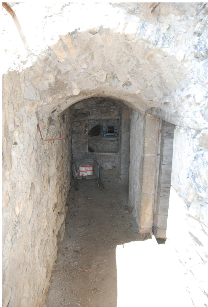
Ferme (2018 H2 543 à 547). Habitation (543), couloir voûté d'accès aux caves.
