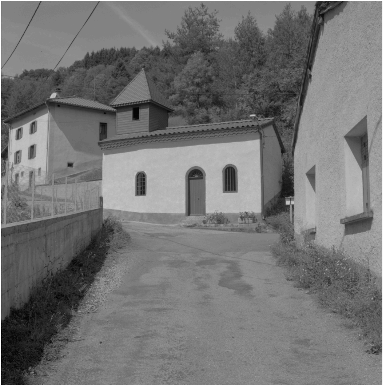
Vue générale de la façade latérale droite.
