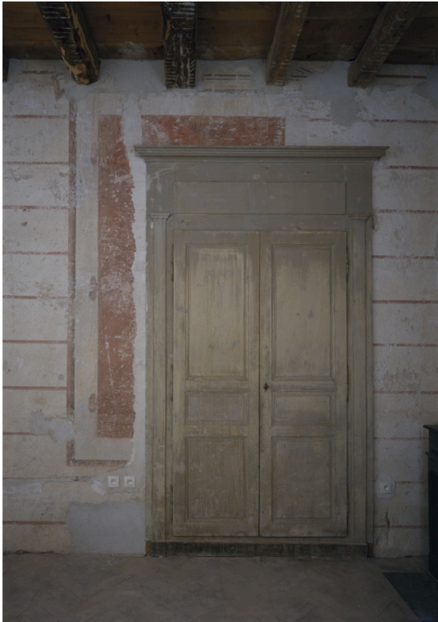
Aile ouest, premier étage, détail des vestiges de l'enduit ancien avec une fausse fenêtre, dans la chambre sud.
