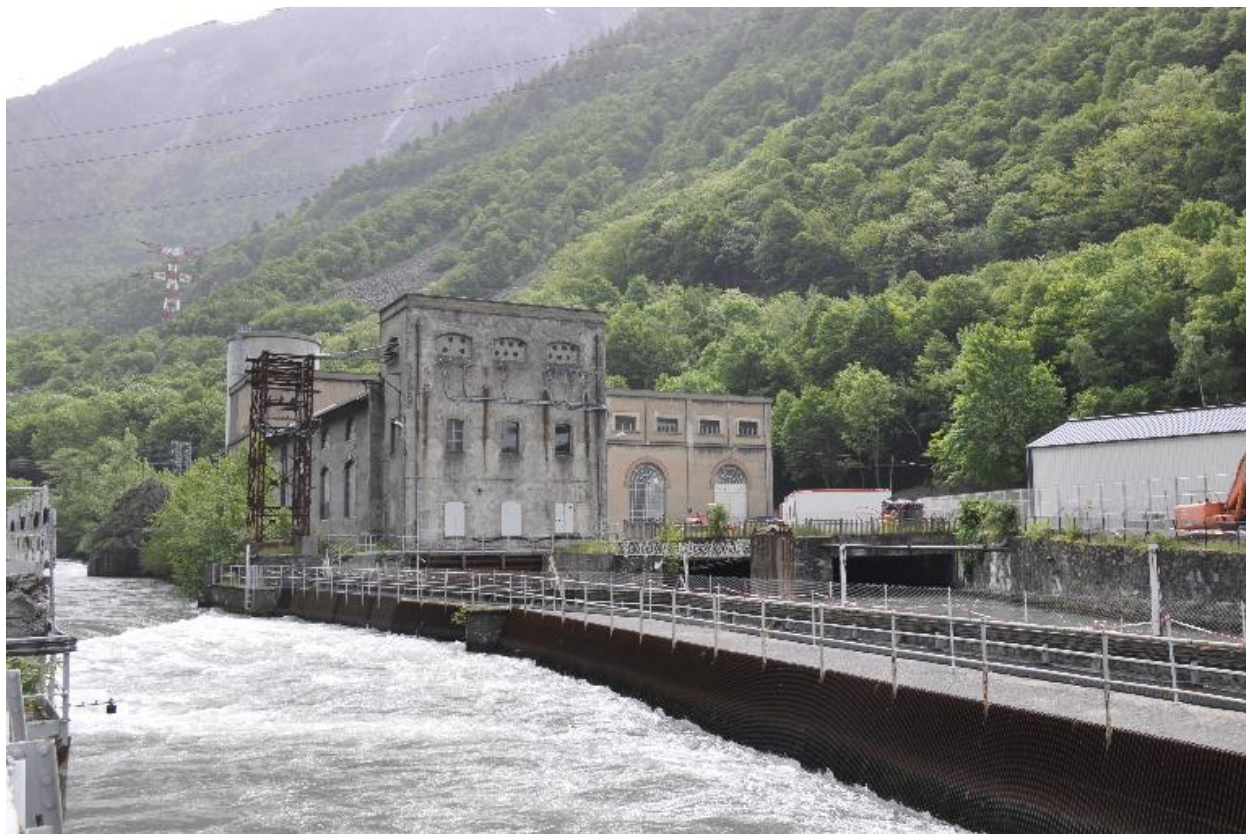
Vue de l'ensemble de la centrale et de la Romanche
