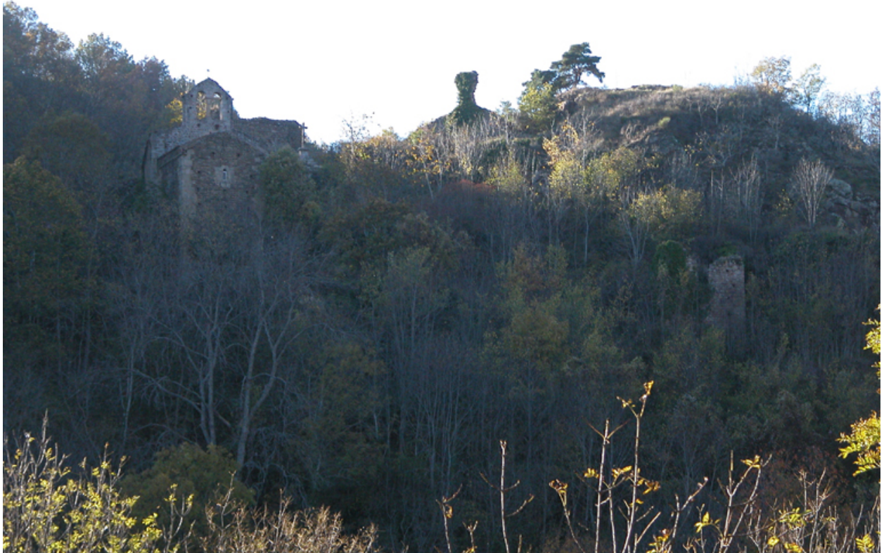
Vue d'ensemble du site depuis l'est.
