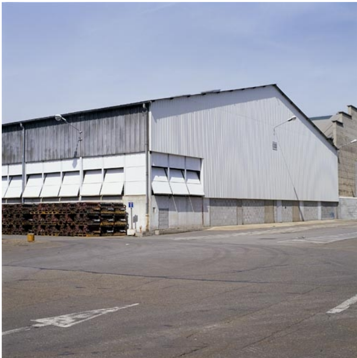
CDIPR, bâtiment CD3, ancienne ligne de mécanisation des autobus et autocars.
