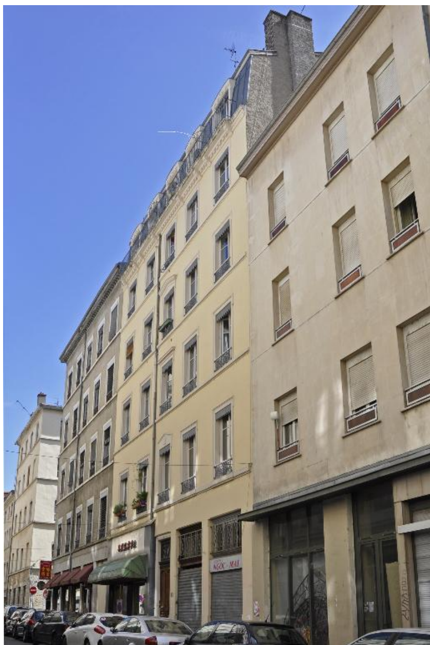
Elévation sur rue, vue générale
