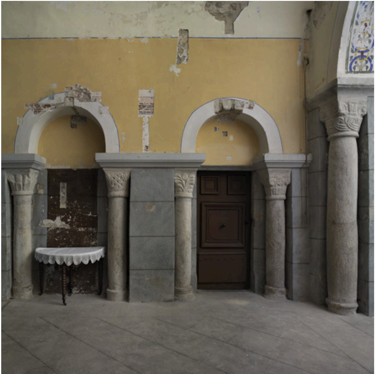
Vue intérieure du mur nord du choeur.
