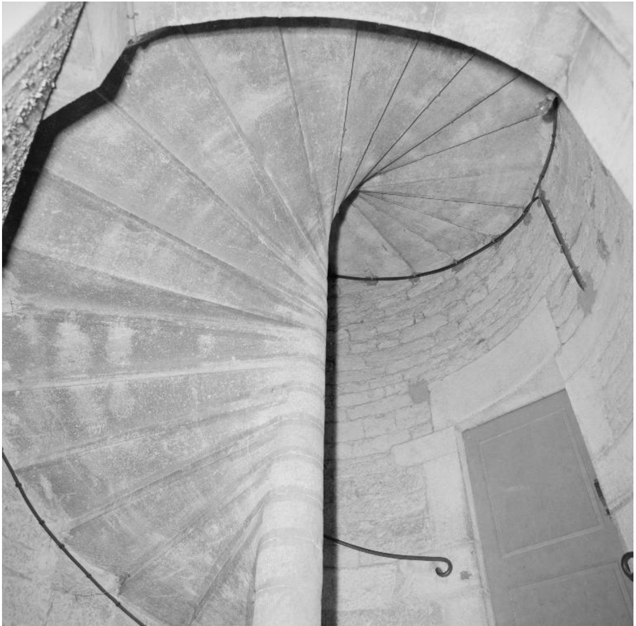
Tour d'angle sud-ouest, escalier de service, détail
