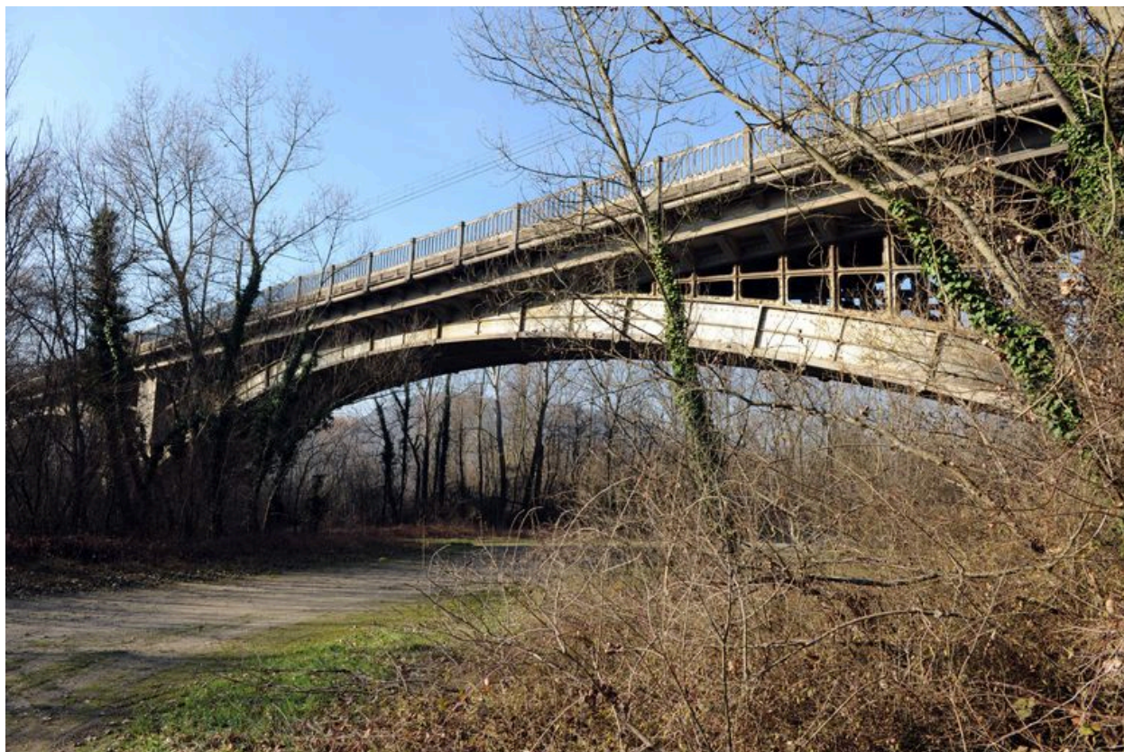
Vue partielle, travée de rive, face aval (depuis la rive gauche)
