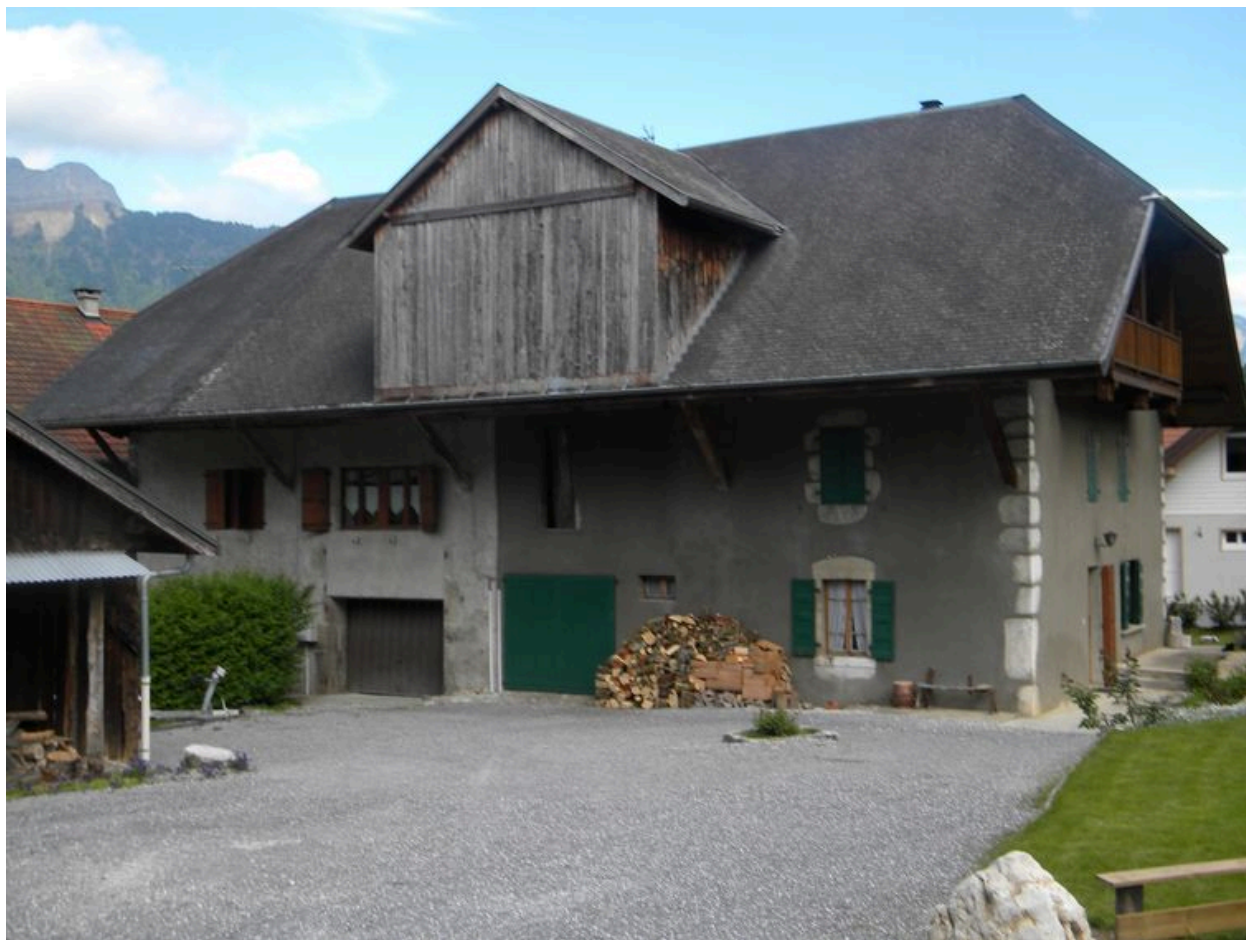
Vue d'ensemble d'une ancienne ferme avec lucarne dans le toit pour le passage d'un monte foin (2008 C8 2624, 2625, 2853).
