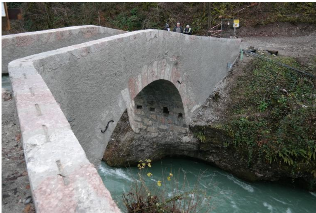
Pont d'Evian vue aval
