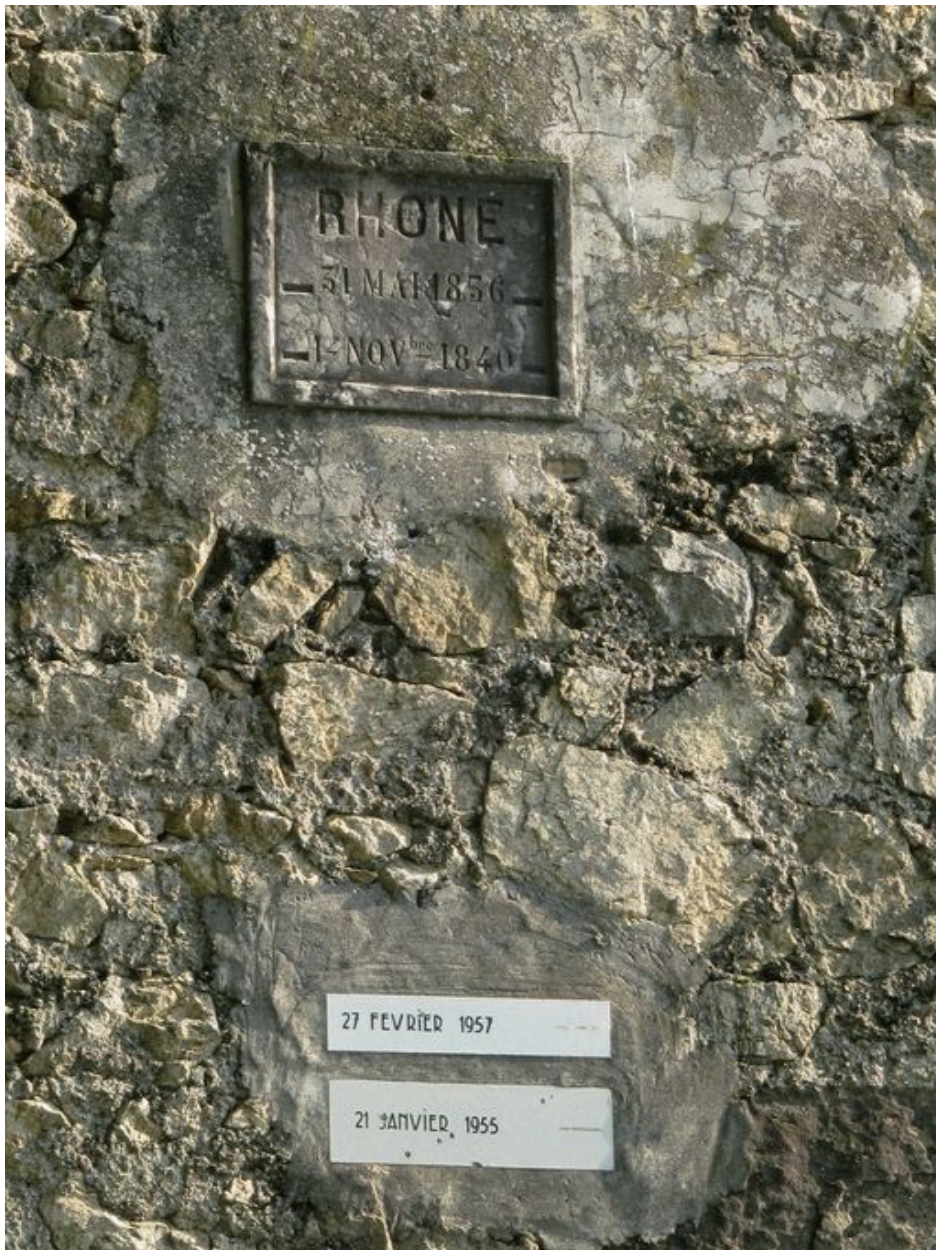
Vue partielle de la face sud : niveaux des crues
