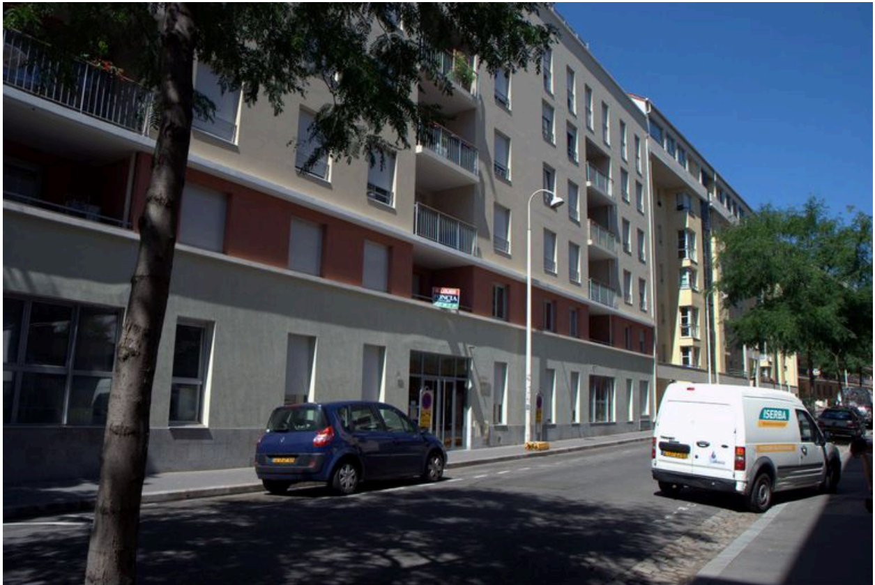
Vue d'ensemble de l'élévation antérieure
