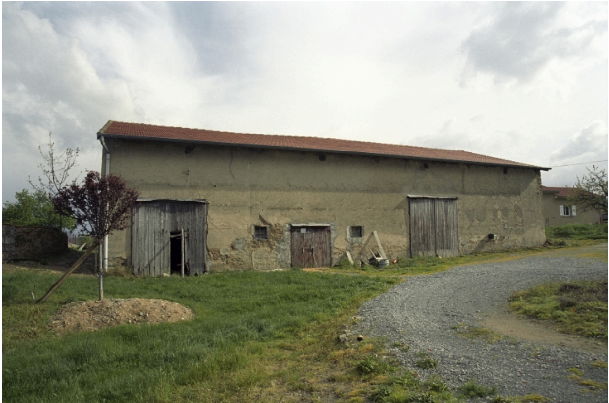
Vue d'ensemble de la grange-étable depuis la deuxième cour.
