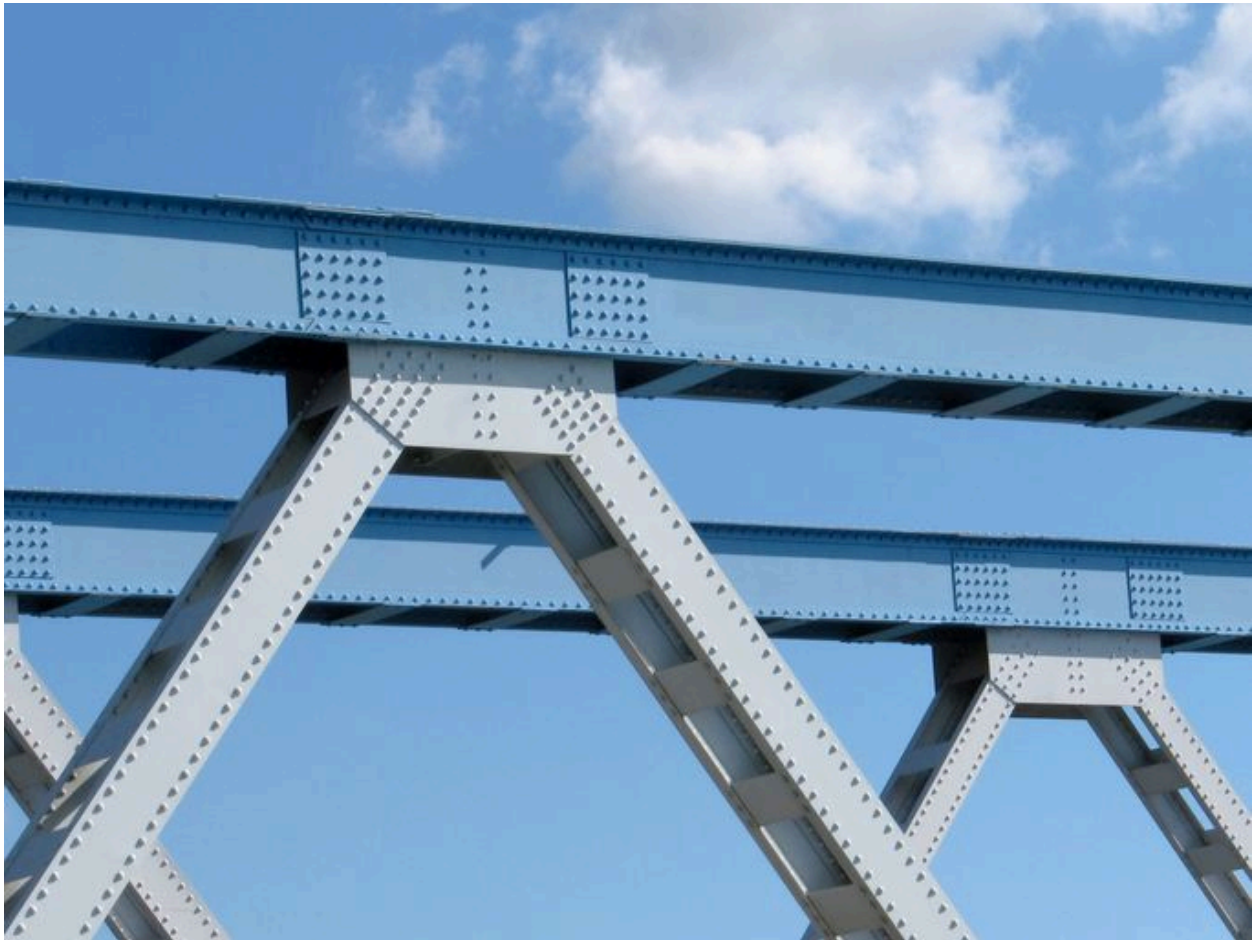
Tablier, face aval, vue de détail : assemblage de la structure (depuis la rive droite)
